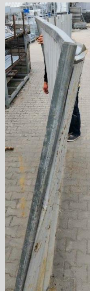
Uszkodzenie niedozwolone – element do KASACJI
