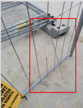
16. Naprawa połączeń zgrzewanych na siatce
