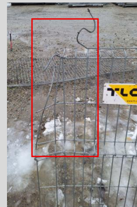
9. Naprawa połączeń zgrzewanych panelu EPS pow. 5 zgrzewów
