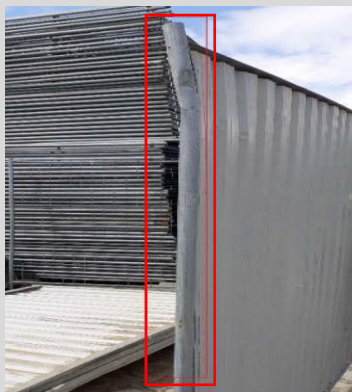
14. Zagięcie słupka pionowego uniemożliwiające naprostowanie
