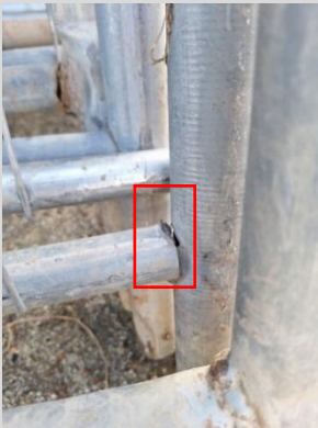
13. Spawy na połączeniach pion/poziom PANEL AŻUR
