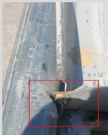
17. Naprawa połączeń spawanych na słupku pionowym
