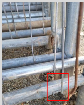
17. Naprawa połączeń zgrzewanych siatka / rura poziom
