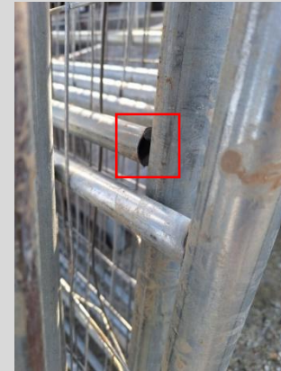
15. Spawy na połączeniach pion/poziom PA- NEL AŻUR
