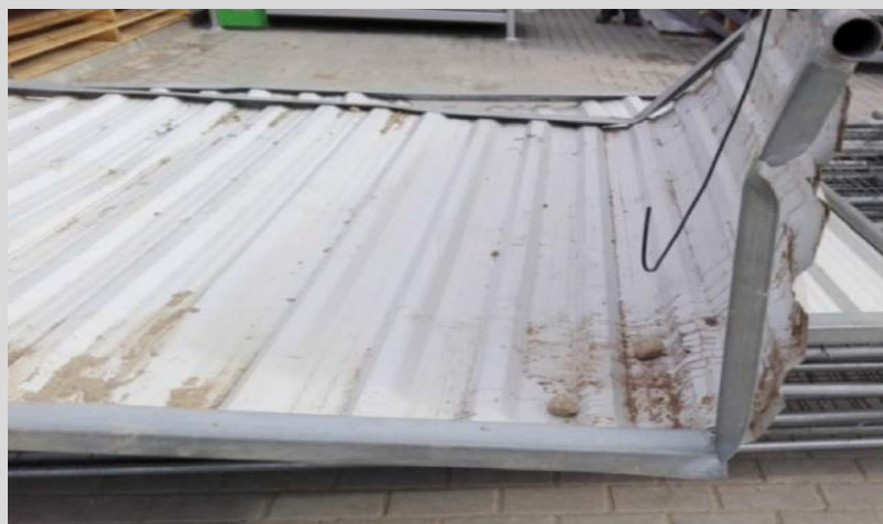
Uszkodzenie niedozwolone – element do KASACJI
