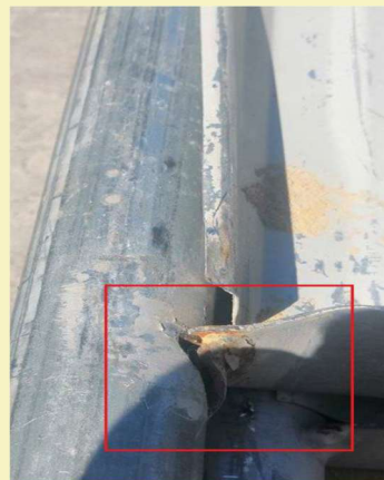
17. Naprawa połączeń spawanych na słupku pionowym
