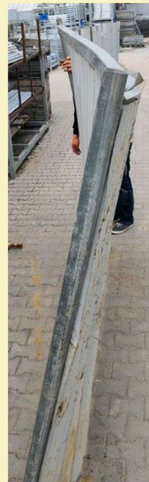
Uszkodzenie niedozwolone – element do KASACJI
