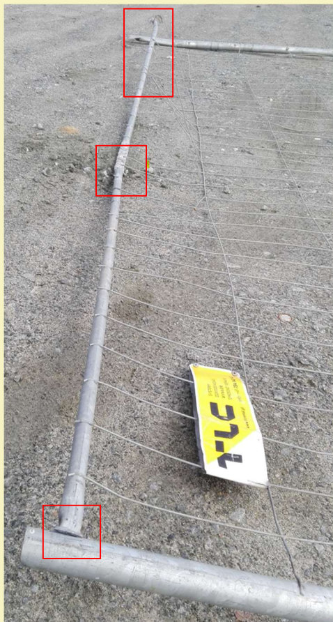
Uszkodzenie niedozwolone – element do KASACJI
